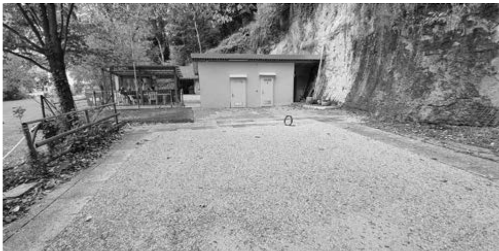
La place, après le démontage de la cantine
